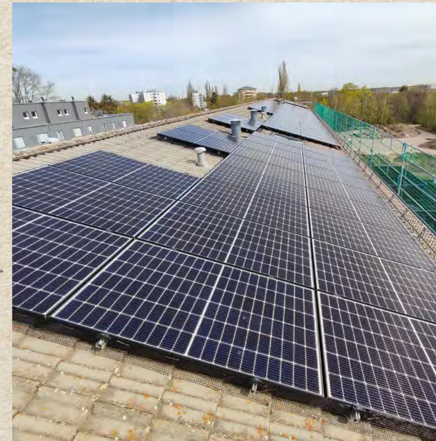
▲ Abb. Montage der Photovoltaikanlage in der Nancystraße 20
